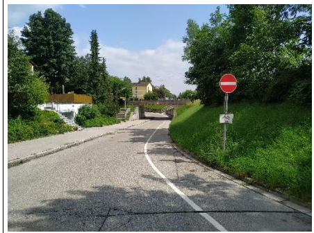
Beginn des Fahrradstreifens an der Sonnenstraße
